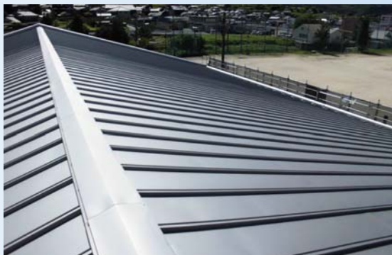
▲ 岐阜県 中津川市内中学校 屋根施工
