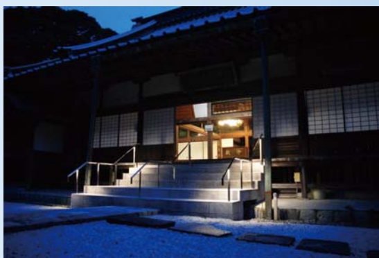
▲ 静岡県牧之原市 平田寺様 LED 手すり
