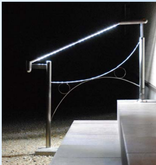
▲ 新築住宅 玄関アプローチ・LED手すり
