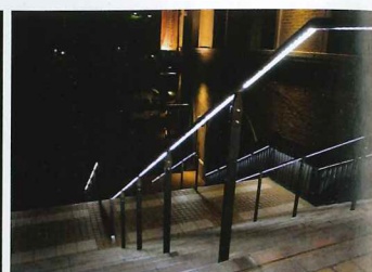
平成26年には「阪神甲子園球場」の屋外階段に総全長100mものステンレス製手すり「みちしるべ」を設置。足元まで明るく、安全になった。度重なる試行錯誤の結果、消費電力は片側の階段で300Wと省エネ化を実現。また、手すりの明るさはリモコン操作で段階的に調光ができる。
